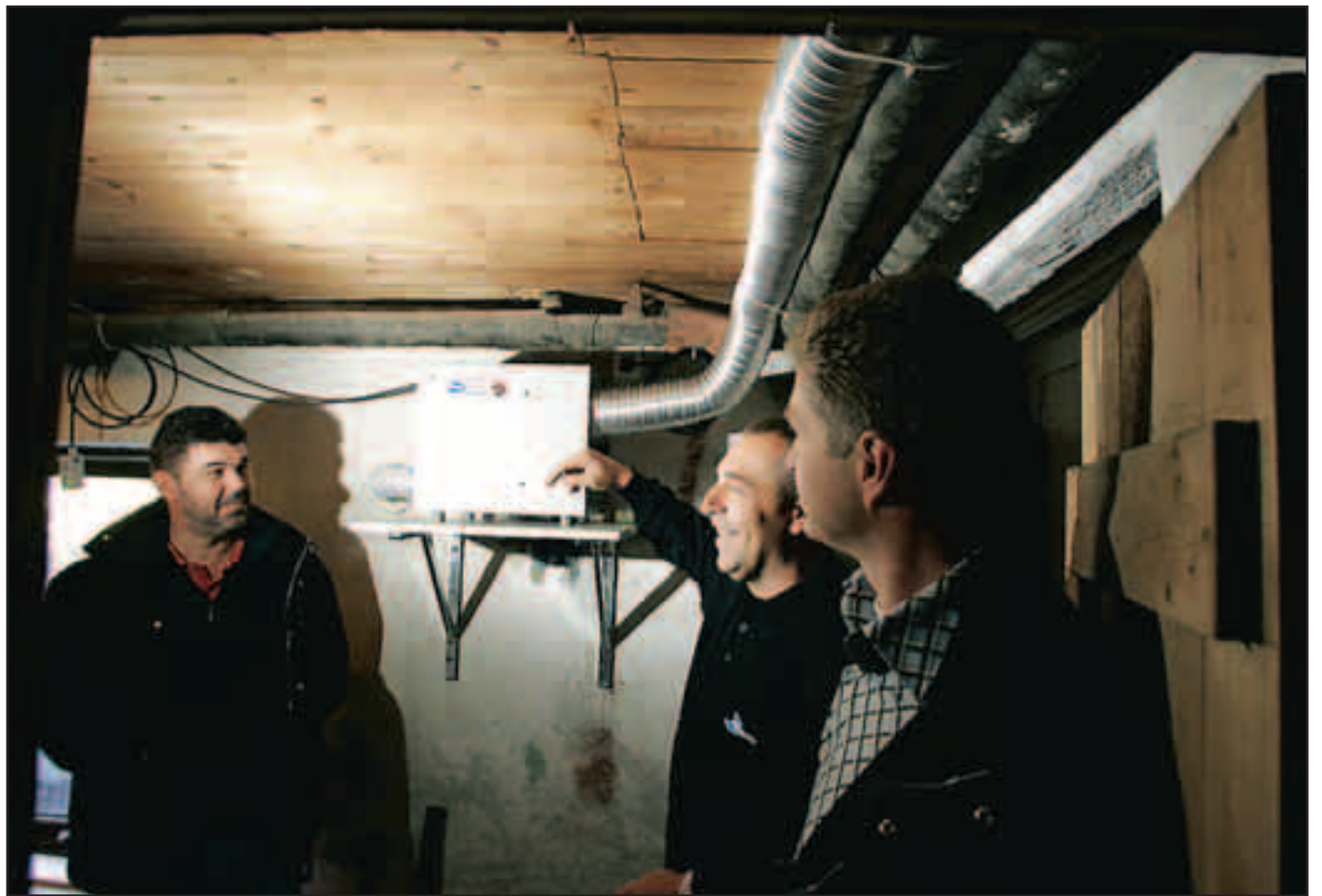
AVFUKTER: – Inni denne boksen roterer det en boks med silica-gelé, forteller Magne Skintveit (i midten) i ABF Service AS. Til venstre Tor-Egil Arnevig, tredjemann er Lars Jåstad.
